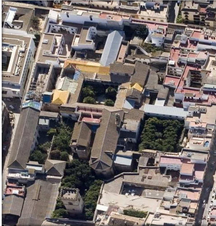
Figura 7. El Real Monasterio de Santa Clara una vez exclaustro. Obras en sus dormitorios para adaptación a uso cultural y restauraciones en el claustro principal
