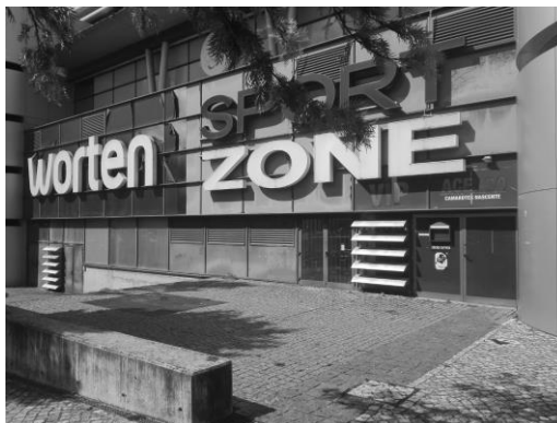
Figura 1 - Estádio Cidade de Coimbra, Rua Dom João III.
