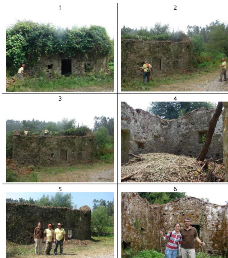
Figura 17 - Processo de limpeza da vegetação da Azenha do Porto Maia com o apoio da Junta de Freguesia de Fornelo - Vila do Conde; Autor: R. Bruno Matos.
