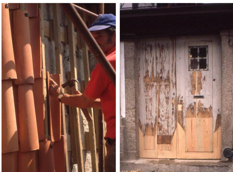
Figura 5 - Detalhes de trabalhos correntes de conservação. GTL/CMG.
